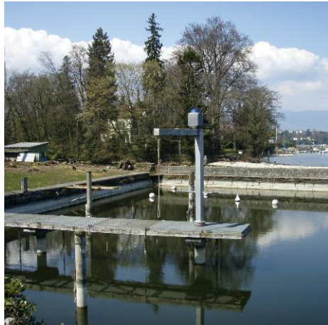
L'embouchure de la Versoix avant... Et après les travaux de renaturation.
