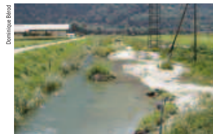
Le tracé du Galdi Kanal en Valais a été rendu moins rectiligne.
