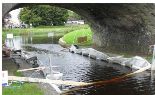
Figure 50: Isolement d'une portion de canal pour réaliser un traitement au Zequanox (Photographie de Sara Meehan). Le graphique représente le pourcentage de mortalité des adultes fixés sur les parois après traitement. D'après Meehan et al. (2014a).
